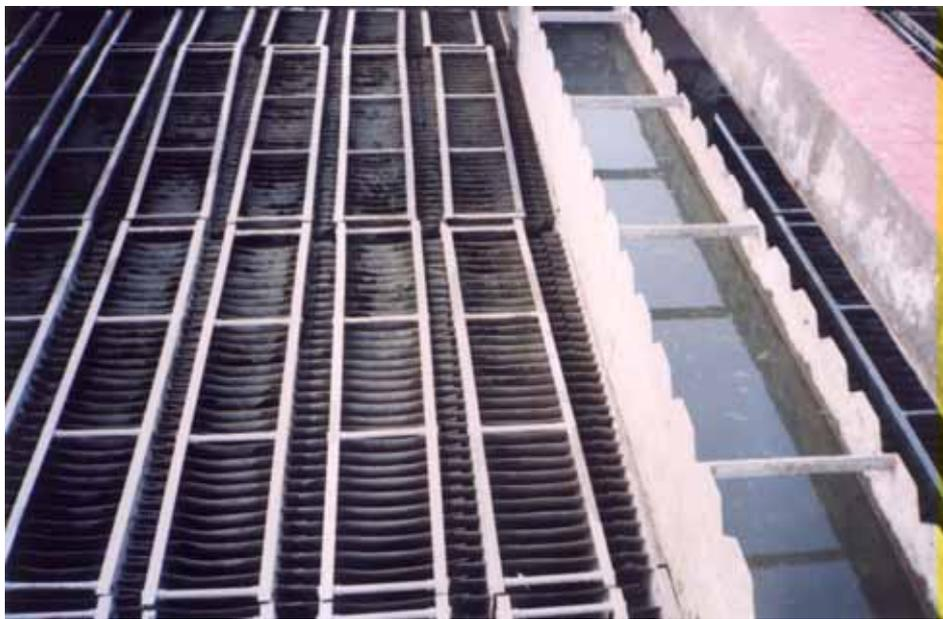
圖 4-7 豐原第一淨水場傾斜板沉澱池與集水渠
