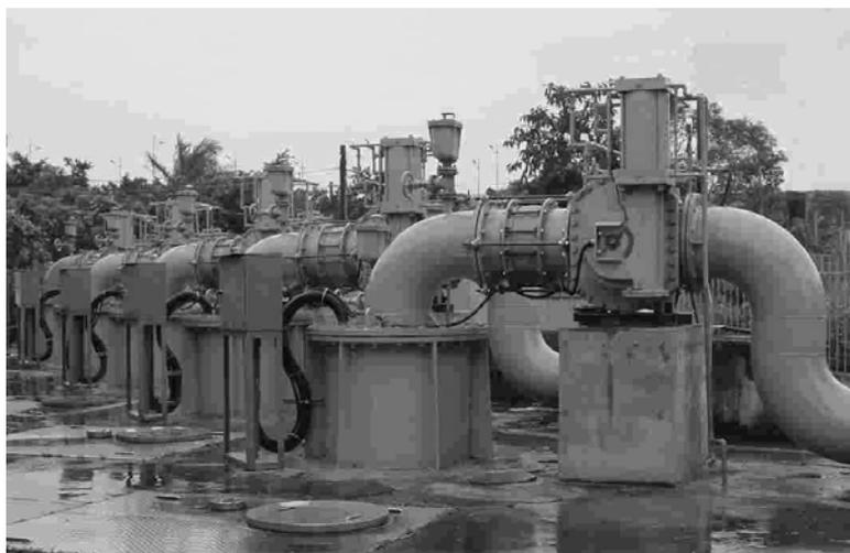
圖 6-2 加壓抽水機設置圖（北投加壓站,沉水式）
