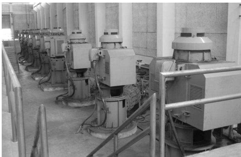
圖 6-1 配水抽水機設置（長興淨水場, 豎軸式）
