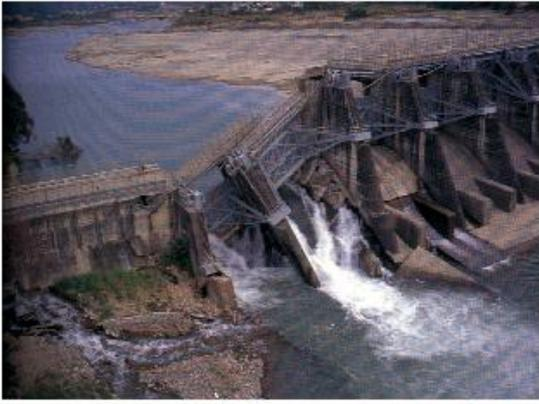
圖 1-4 台中石崗壩的損害情形
