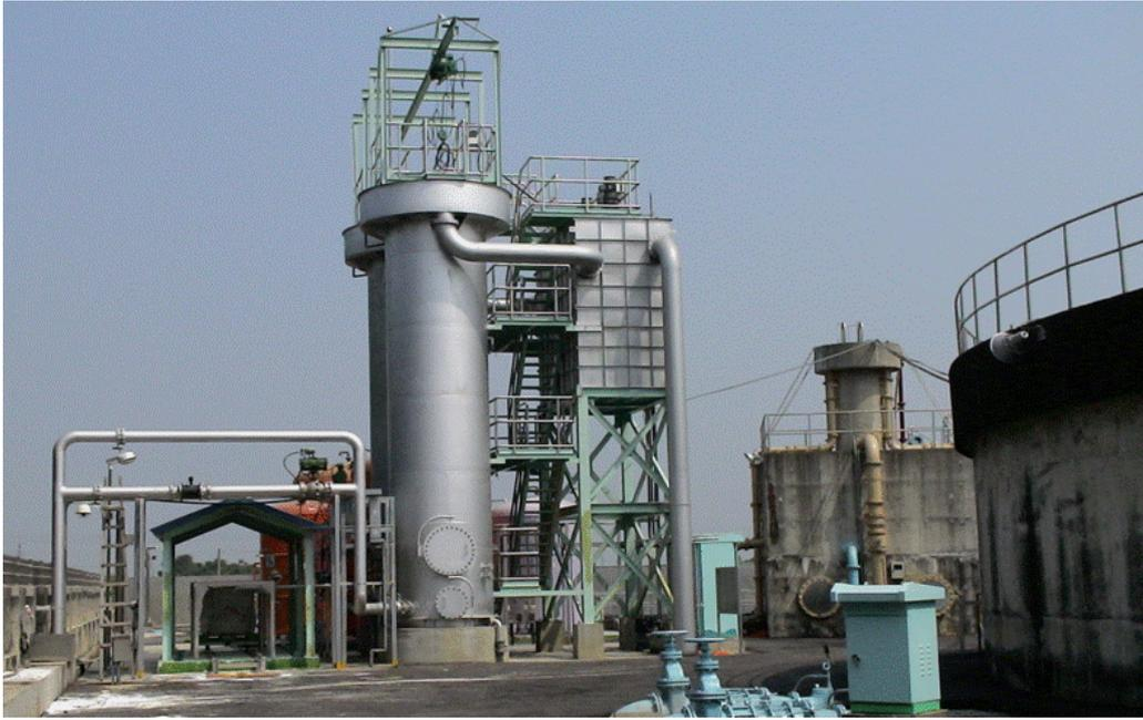
圖 4-21 雲林荊桐淨水場流體化床結晶設備圖
