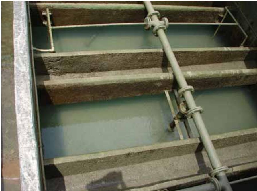
圖 4-16 快濾池表洗裝置圖（潭頂淨水場）
