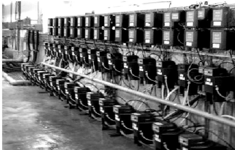
圖 7-7 水質儀器安裝圖（直潭淨水場濁度連續監測）
