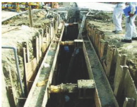
圖 8-9 管溝開挖應設擋土支撐
