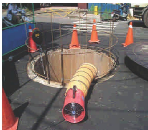
圖 8-7 窰井通風設備配置
