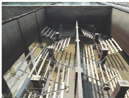
圖 1-11 水平軸式膠羽池
