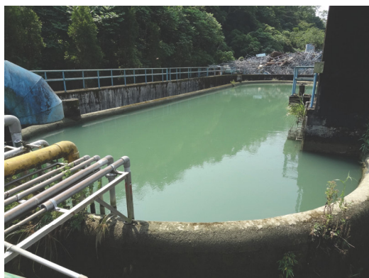
圖 1-8 淨水場沉砂池
