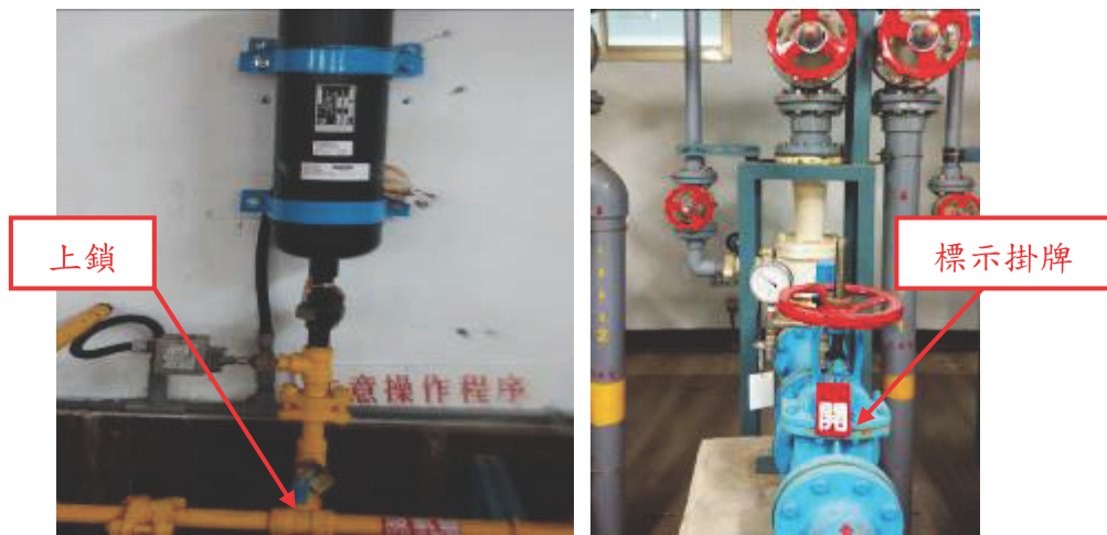
圖 5-8 開關上鎖與標示掛牌防誤動作
