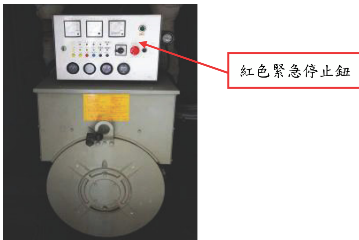
圖 5-9 緊急制動裝置
