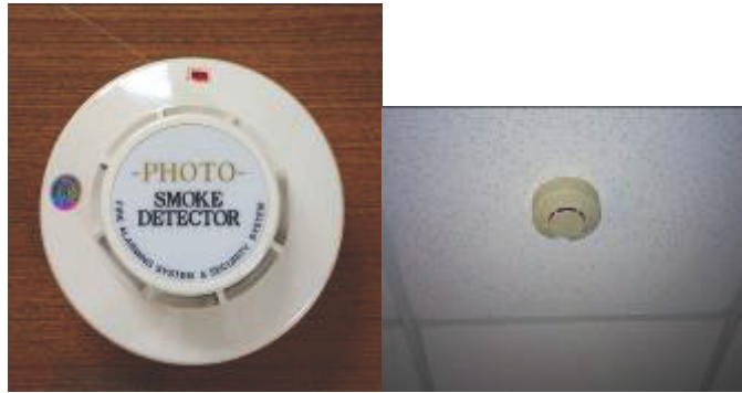
圖 5-17 光電式偵煙器設備
